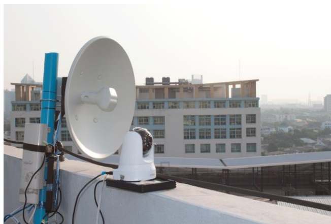
รูปที่ 5.1 การติดตั้งอุปกรณ์
