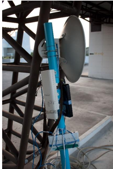
รูปที่ 5.2 การติดตั้งอุปกรณ์
