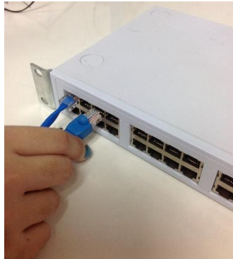
รูปที่ 8.4 การเชื่อมต่อแอคเซสพอยต์กับสวิตช์ เมื่อติดตั้งสมบูรณ์ภาพรวมของระบบเป็นดังรูปที่ 8.5
